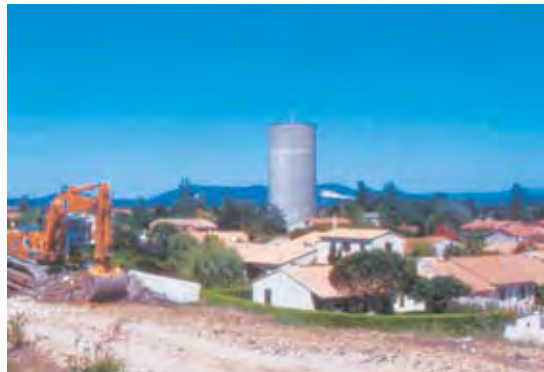
Château d'eau route de La Garde à Pierrelatte en forme de tour circulaire d'une capacité de 1500 m 3 .
