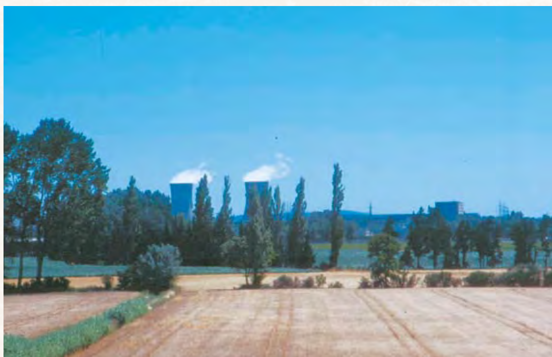
Les tours de refroidissement et leur environnement agricole, sur Pierrelatte . AmP : 66Fi54, fds M.de la Drôme, cl.R.Aggou, 2000.
