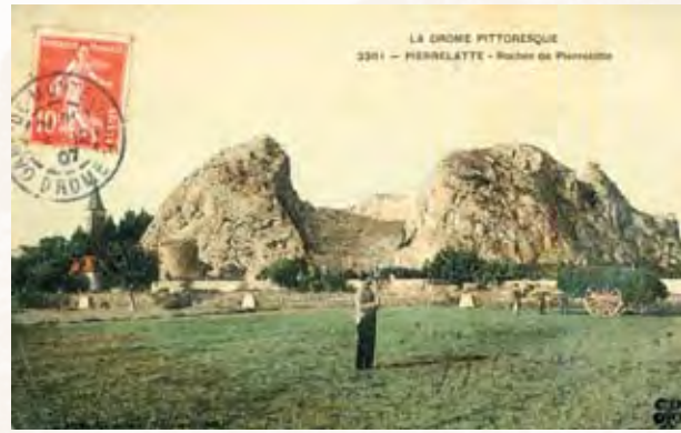
Le Rocher de Pierrelatte , avant 1907, depuis le nord-est vers la fin de son exploitation comme carrière de pierre. Le « trou » ne sera bouché qu'en 1953 par le château d'eau édifié au lendemain de la construction du canal de Donzère-Mondragon.
