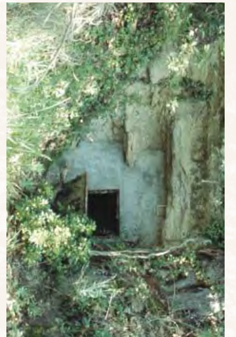
Entrée de galerie de source au Chameau à Saint-Paul.
