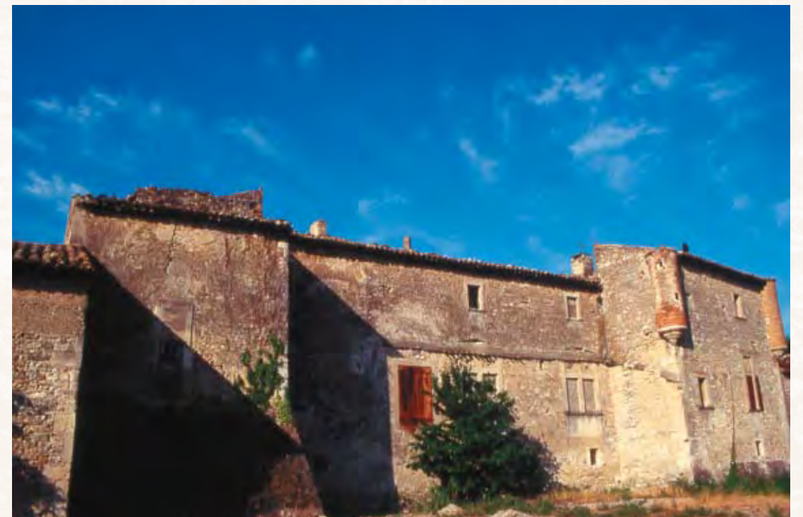
Le Château de Frémigières sur sa façade nord du côté de Pierrelatte.
