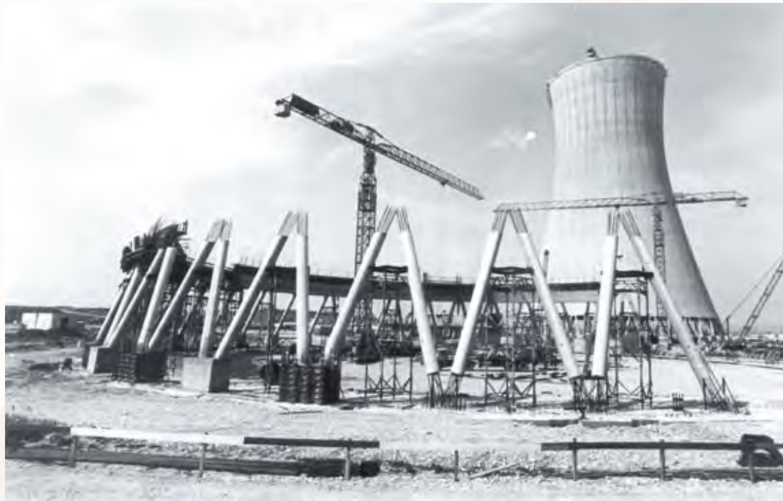
Construction sur Pierrelatte des tours de refroidissement de la Centrale nucléaire en 1977. AmP : 36Fi1, fds Eurodif, 1977.
