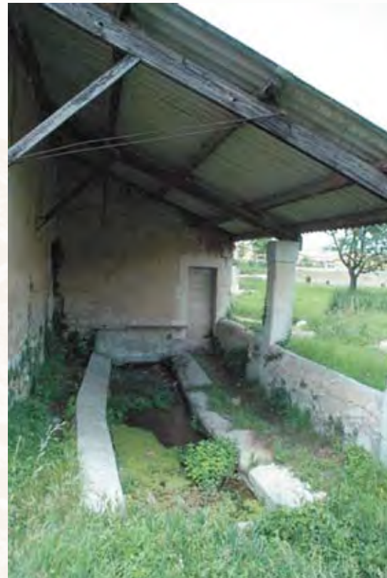
Lavoir à Saint-Vincent à Saint-Paul à proximité de la mare du même nom.
