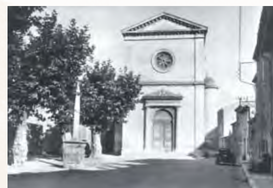
Façade ouest de l' Église de Pierrelatte avec son ordonnancement à deux frontons sur porte et sur toiture séparés par oculus et corniche.
