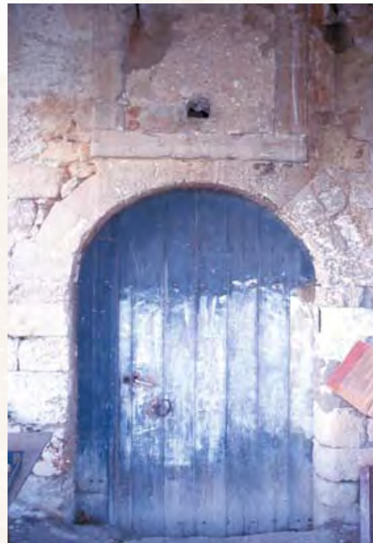
Porte d'accès aux caves du Château de Saint-Paul , surmonté s'un cadre pour blason.
