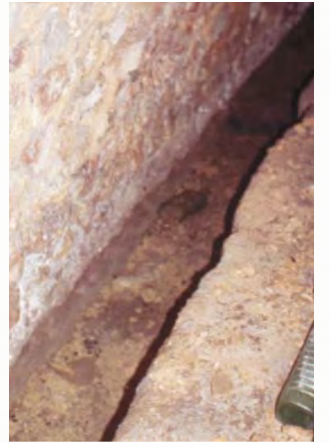
Cave de maison rue des Grandes Fontaines à Saint-Paul, lieu de résurgence par forte pluie.
