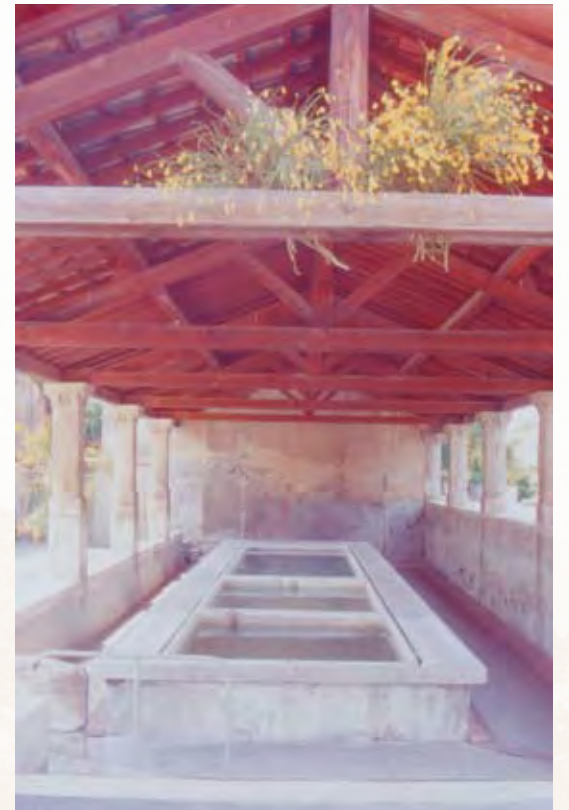
Le lavoir, route de Bourg à Pierrelatte , pourrait dater initialement de 1780. Agrandi en 1821, il est doté d'une toiture en 1863.
