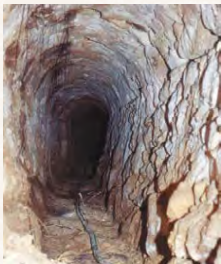
Une des galeries de conduite des sources des Frères maristes au quartier de Boussous .
