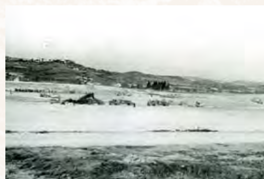
Le chantier du canal à hauteur de la Garde Adhémar . AmSP : 109Fi14, fds Hernandez, sd
