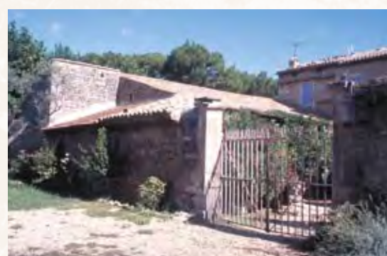
Entrée de la Calamande , situé au nord de Chamier.
