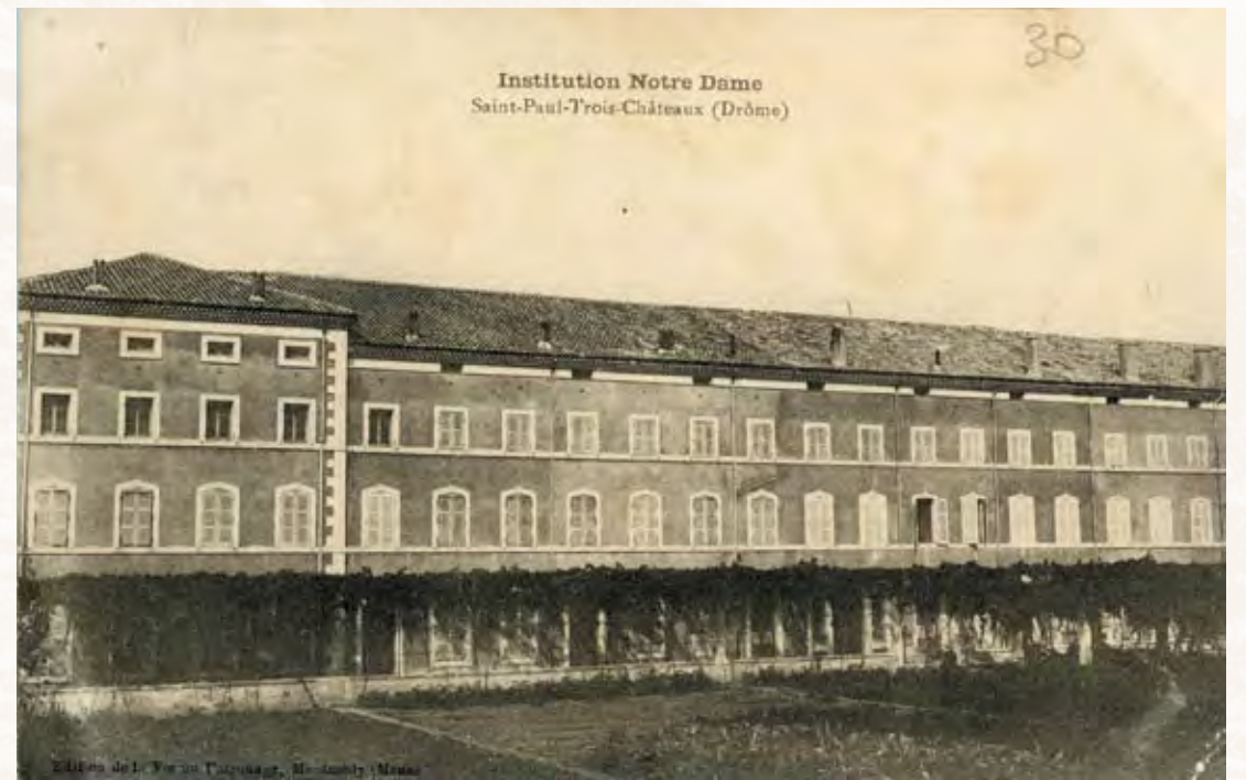
Façade sud de l' Établissement des Frères maristes à Saint-Paul avant 1913. La chapelle est à l'opposé, côté nord. AmSP : 98Fi214, fds Souchon/Messié, carte écrite en 1913.
