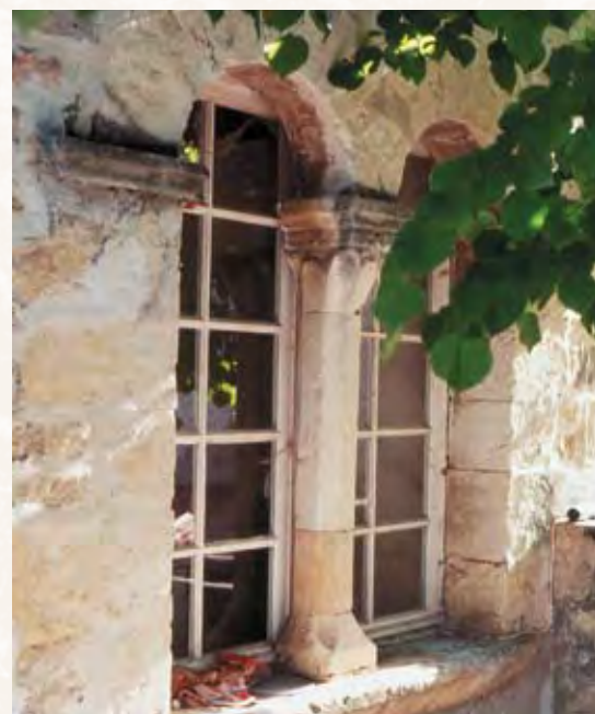
La mention la plus ancienne de la chapelle de Sainte-Foy remonte à 1217. Érigée en 1776 en église succursale, elle perd toute fonction religieuse à la Révolution. Aujourd'hui, il ne reste quasiment rien de la chapelle hormis une élégante ouverture romane. AmP : 15Fi130, cl.O.Mondon, 1992.
