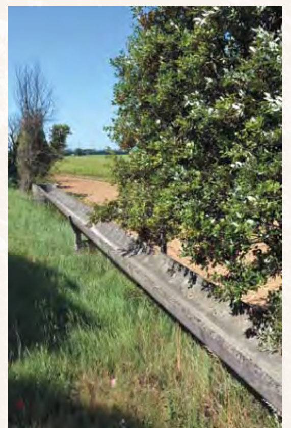
Aqueduc sur Saint-Paul, près de Bollène , construit dans le cadre du volet « Irrigation » du canal de Donzère-Mondragon, vers 1955.
