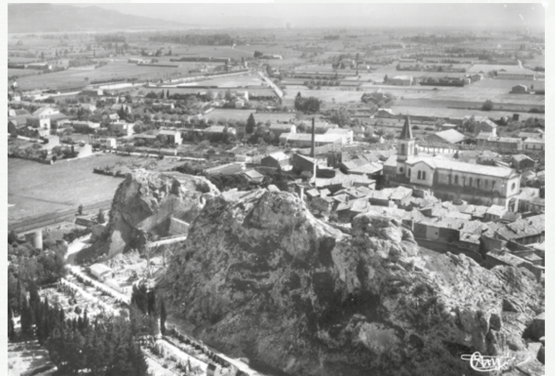
Chantier de construction du réservoir du Rocher, 1953
