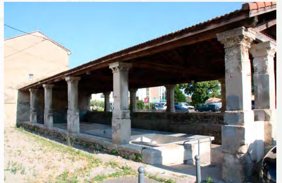
Lavoir, Route de Bourg, qui n'est plus utilisé, avec le côté nord rouvert, 2015.
