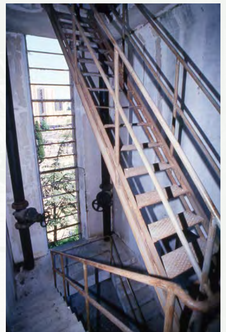
Escalier central à l'intérieur du réservoir du Rocher, 1995.
