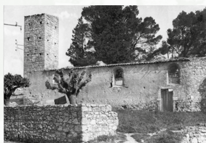
La chapelle pas encore dotée de sa nouvelle toiture, 1942.
