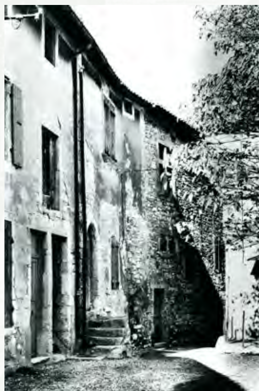
Rue du Château, maisons qui prolongeaient l'hôtel dit des Gouverneurs vers l'Ouest, vers 1975.
