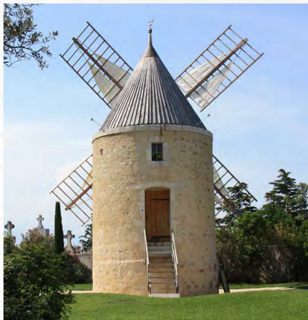
Moulin à vent restauré avec ses ailes et ses toiles, 2012.
