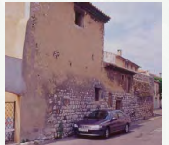
Rempart ouest au niveau de l'actuelle place de la Liberté, 2000.
