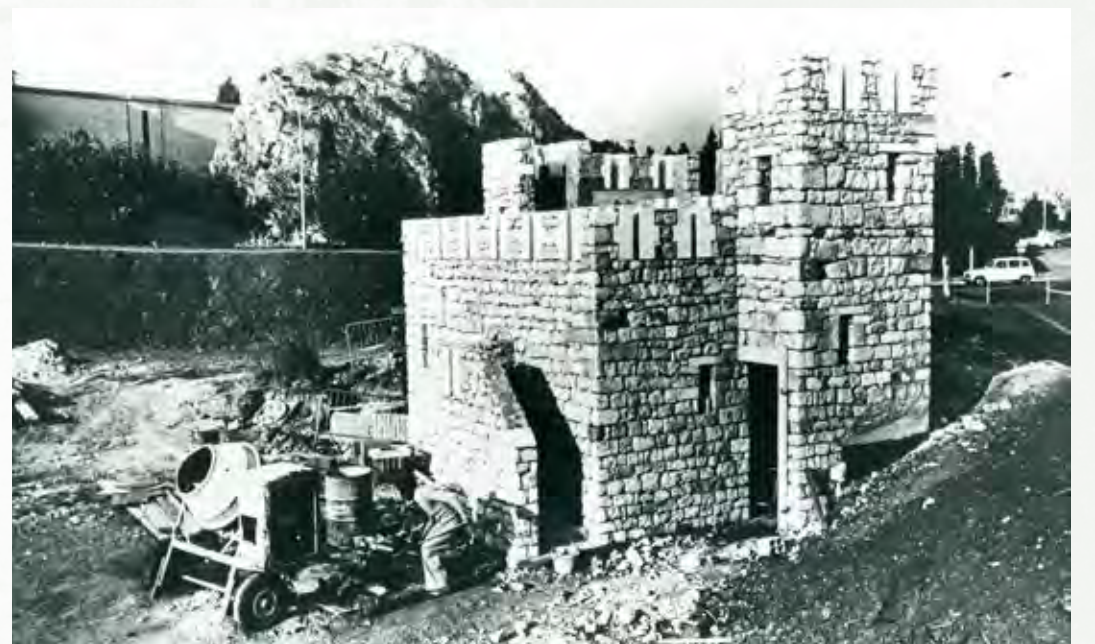
Le « château » construit entre Rocher et quartier du Roc, 1979.
