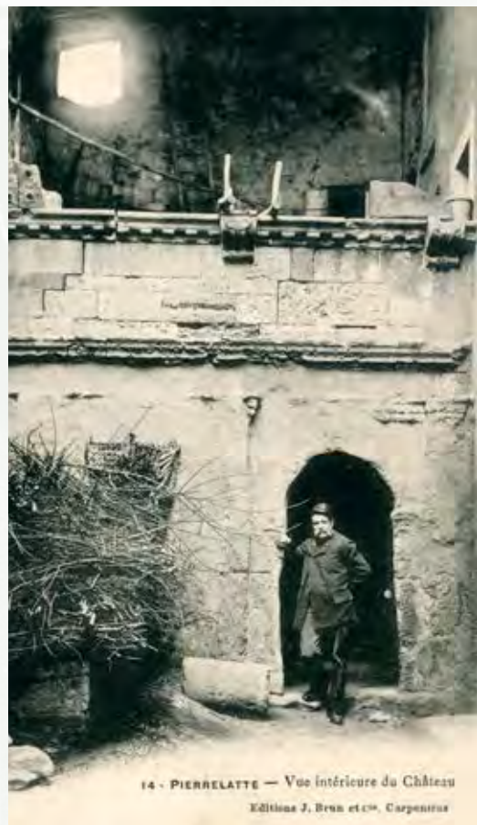
Porte et galerie d'accès à la partie habitée de l'hôtel dit des Gouverneurs avec un garde champêtre communal, vers 1910.
