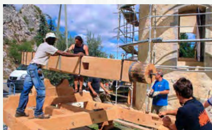
L'arbre moteur qui transmettra la force des ailes actionnées par le vent, en cours de positionnement, 2011.
