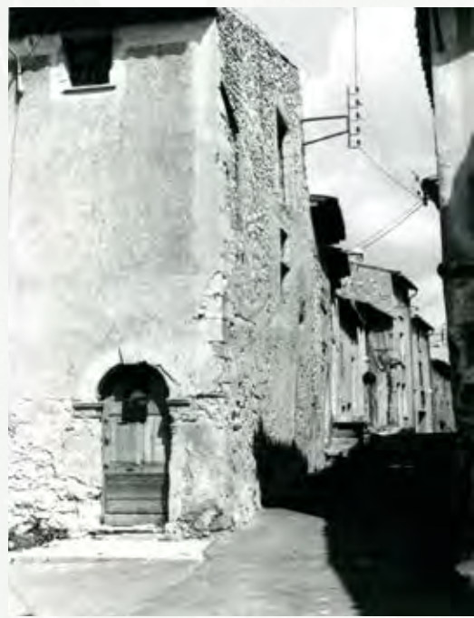
La même maison peu avant sa démolition vers 1970.
