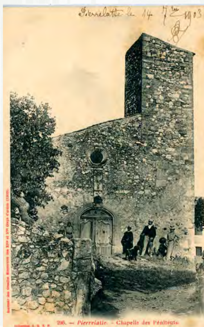
Façade ouest de la Chapelle des Pénitents, édifice alors privé, 1903.
