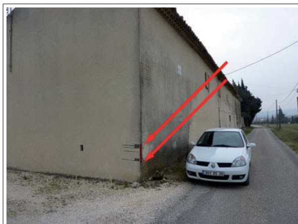
Repère n°1 : quartier les Perrotines, sur le mur d'une maison
