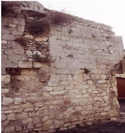
Tour rue de l'Archange, depuis la rue, côté ouest.
