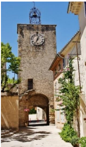
La tour de Richerenches, qui est surmontée d'un campanile en fer forgé protégeant une cloche.
